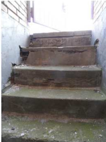
Nedbrudte betontrin og væg med skader
