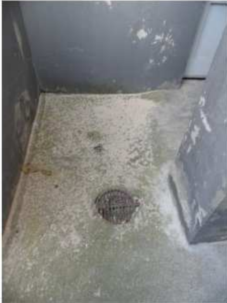
Afløb i trappeskakt
