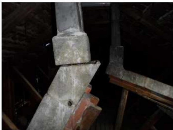
Ødelagt aftrækskanal
