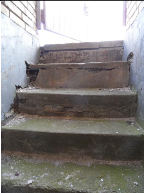
Nedbrudte betontrin og væg med skader
