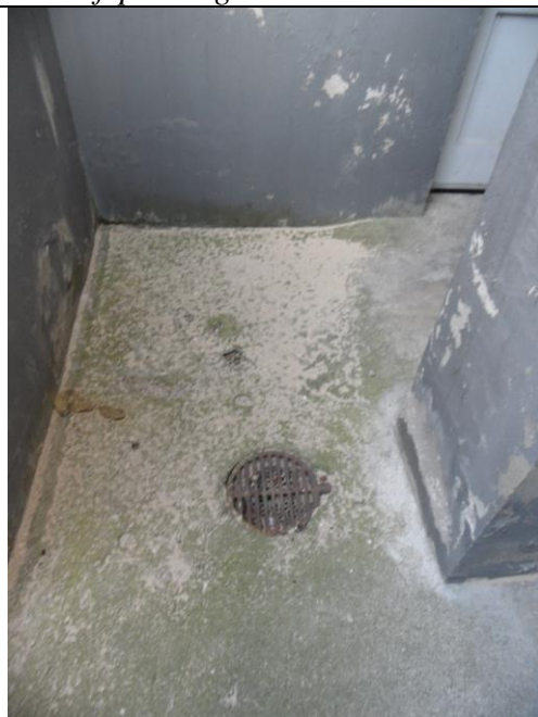
Afløb i trappeskakt
