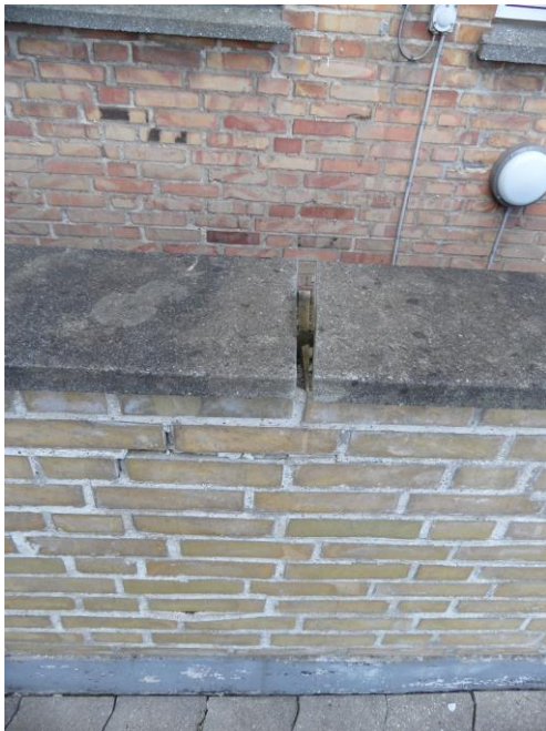
Nedbrudte betontrin og væg med skader
